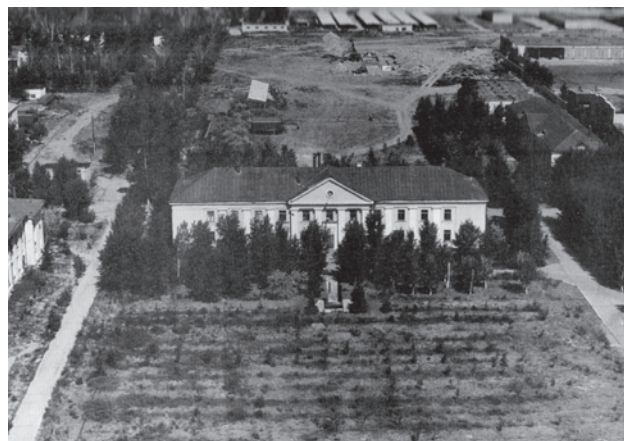
Территория Опытно-научной части, старое здание штаба (конец 50-ых-начало 60-ых гг.), ныне здание Административного корпуса ИРБЭ
