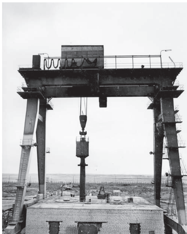
Установка перегрузочного контейнера на люк помещения досборки (пом. 03)
