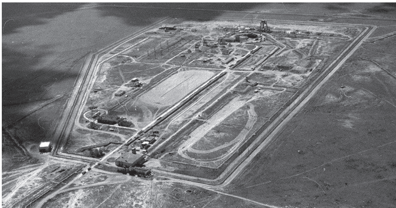
Строительство КИР «Байкал-1»
